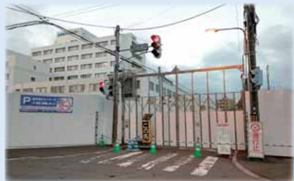
道路を封鎖して上空通路工事を実施しています
