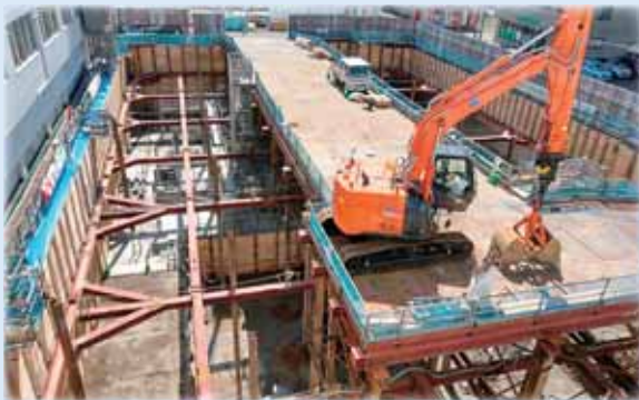
本館：掘削作業の状況
