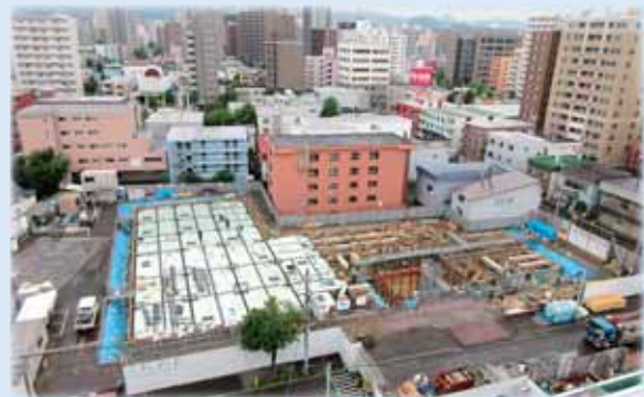
別館：基礎躯体工事の状況
