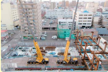
本館の工事の様子
