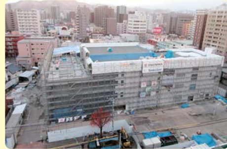
別館の工事の様子
