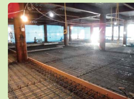
本館内部…床スラブの鉄筋組立作業を実施
