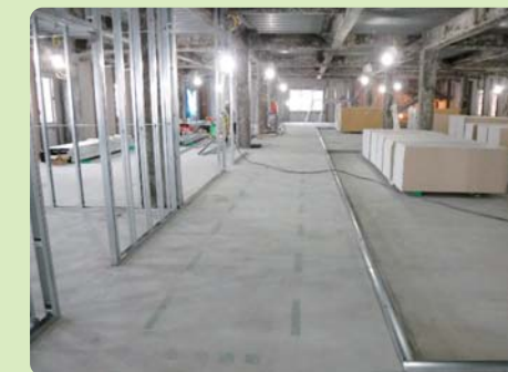
別館内部…耐火間仕切下地を組立作業を実施
