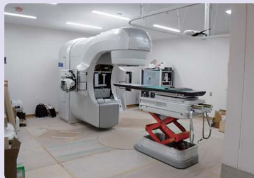
(本館) 本館地下1階：リニアックを設置しています
