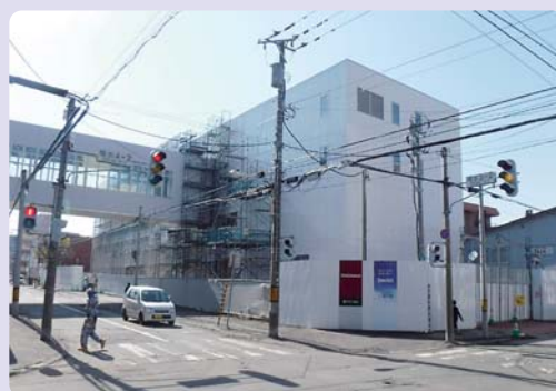
(別館) 別館外観：本館とつながる上空通路が完成しました
