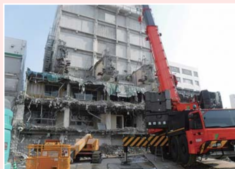
①大梁解体工事
