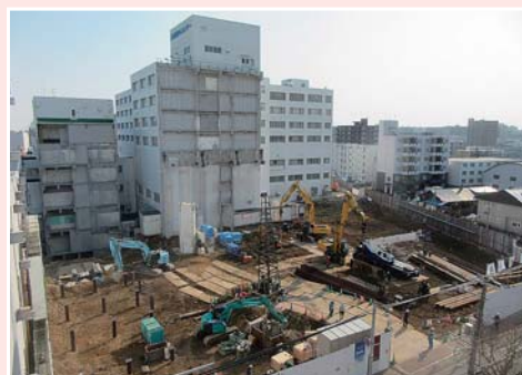
②新棟高層部の新築工事が着手
