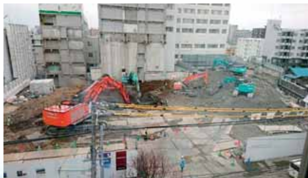
菊水3号線を挟んで別館から旧棟を撮影 (2019年3月6日撮影)
